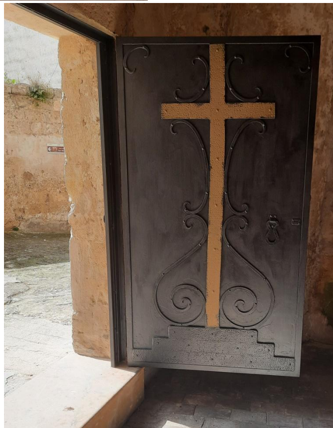
Sotto il campanile senza campana, aggiunta solamente successivamente una piccola campana, presentava la porta che storicamente era una porta di legno con chiave e serratura ben accomodata.
